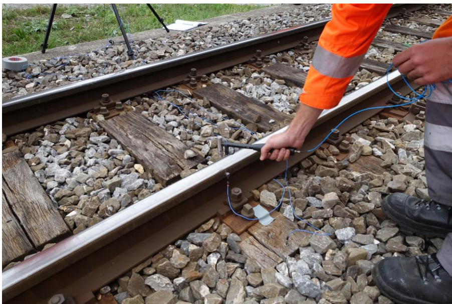
Abbildung 15: Hammermessung an Fahrbahn mit Holzschwelle
