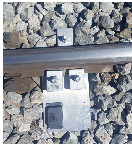
Montierte RFID Tags detektieren Start und Ende der Sprühvorgänge.
