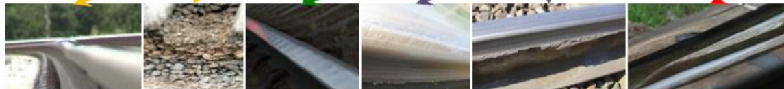
Gleislageverschlechterung Schotterzerstörung
