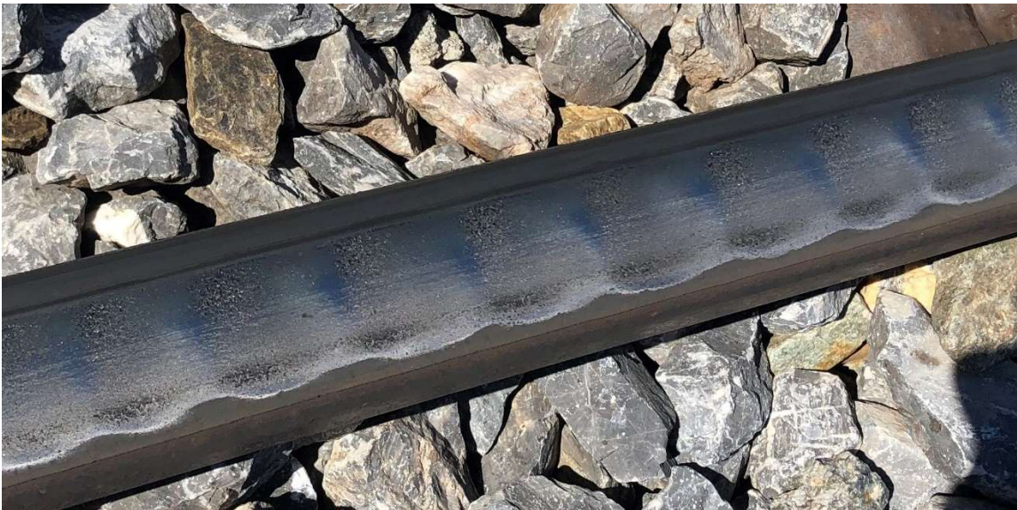
Abbildung 14: Schlupfwellen Bogeninnenschiene
