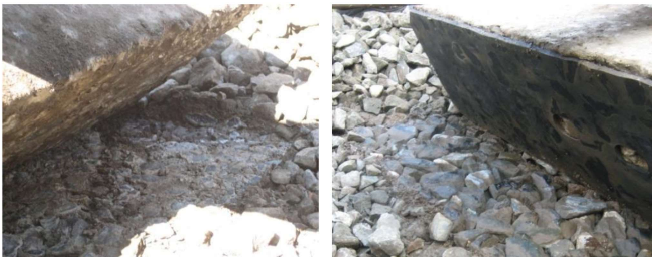
Abbildung 21: Schotterzustand nach 100 Mio. Lasttonnen mit und ohne Besohlung
