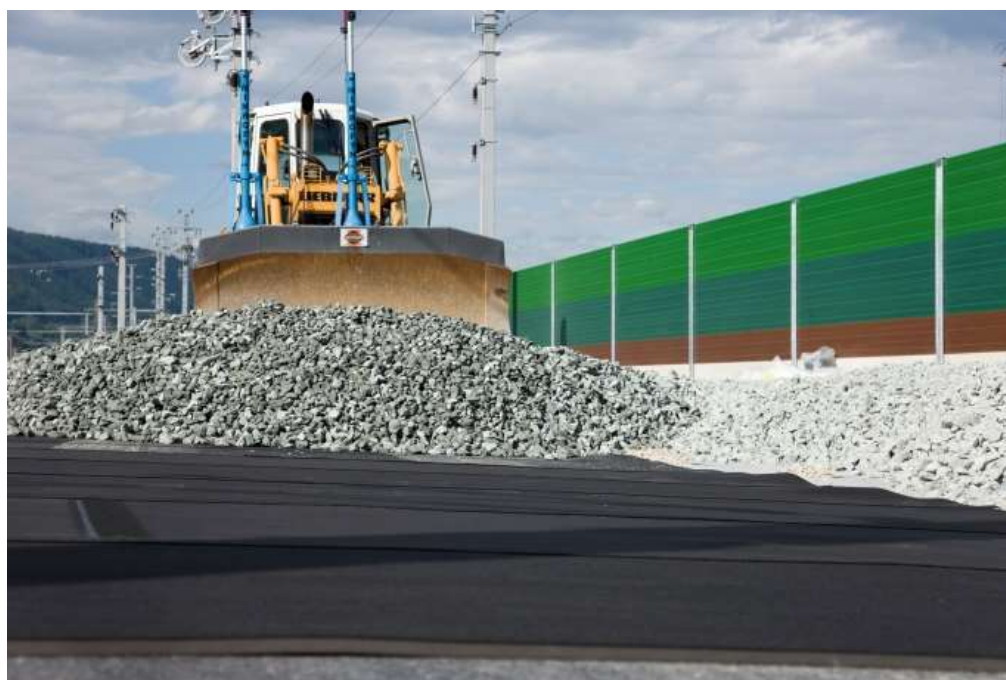
Abbildung 24: Einbau von Unterschottermatten
