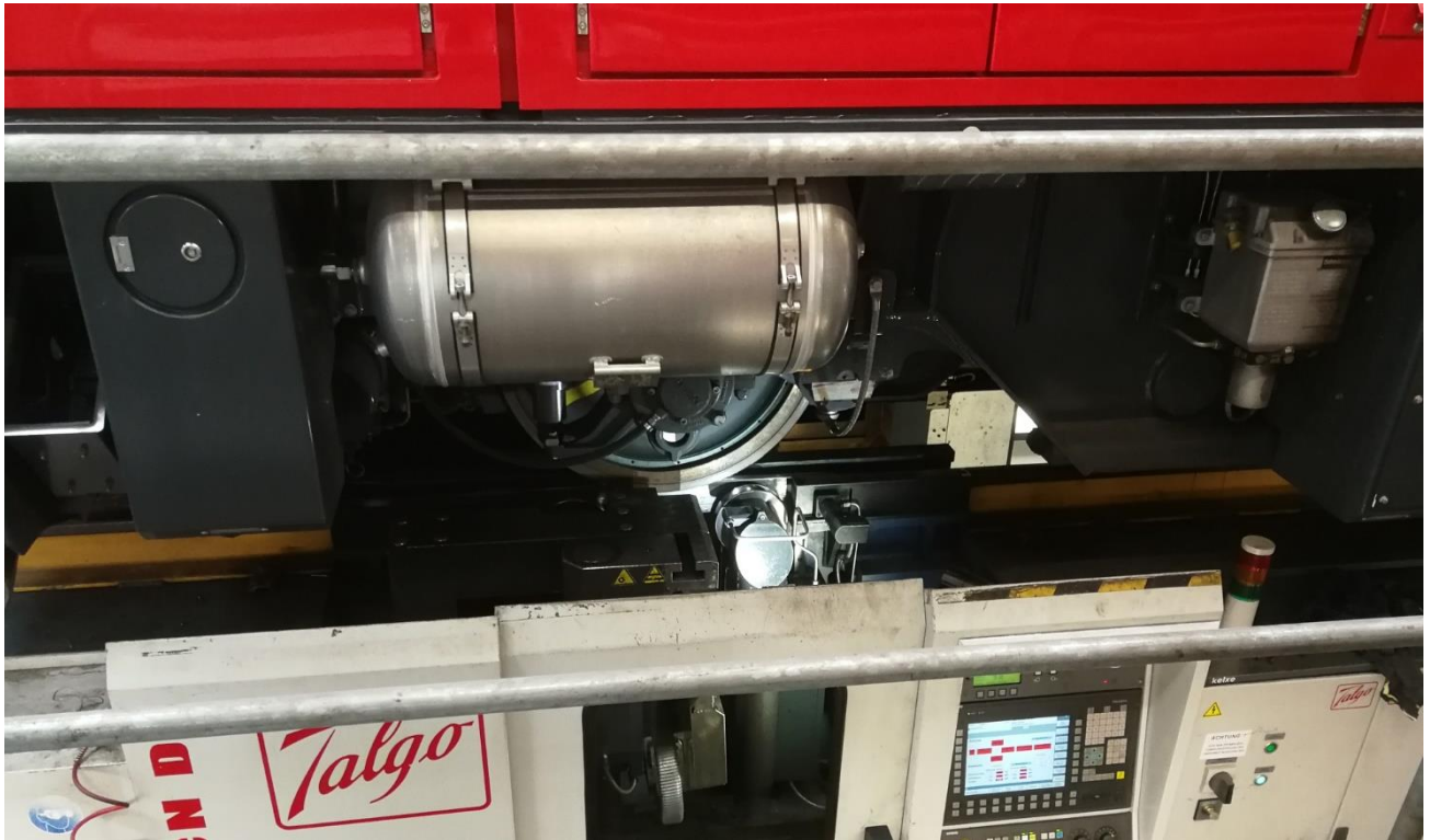
Unterflurdrehbank MGB mit Fahrzeug «Tea 2/2» (Quelle. MGBahn)
